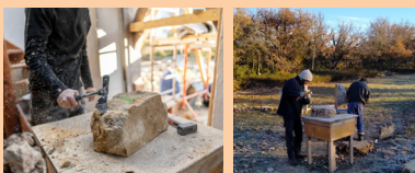
Construction des murs en pierre et des premières ouvertures
