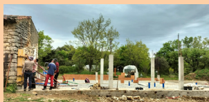
Coulage des dalles en béton de chaux
