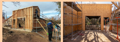
Mise en place de l'ossature bois pour le hangar
