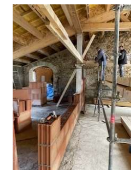
Charpente - cloison séparation ateliers appartement - décembre 2025
